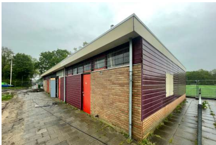
Het oude kleedkamergebouw diende lange tijd als opslag van materialen en ballen
